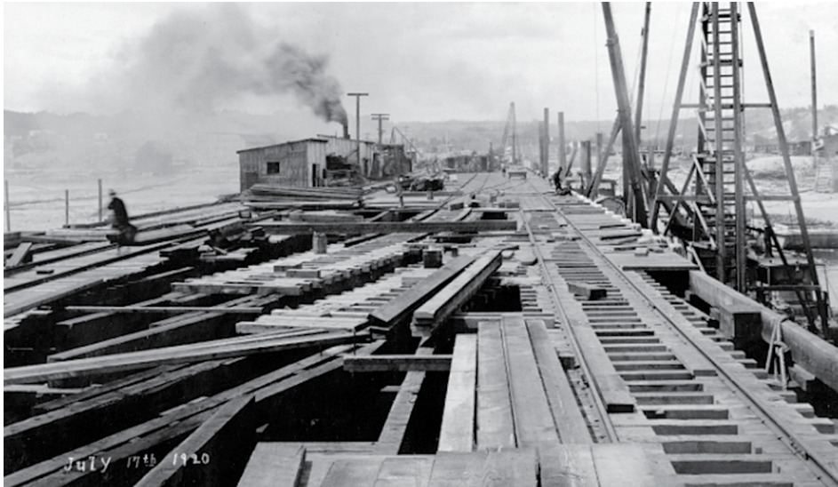
Construction du quai de Port-Alfred à La Baie en 1920. (Photo: Source : BAnQ)
